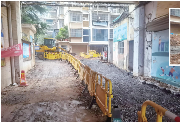
大观区花好悦园 小区改造施工现场。
