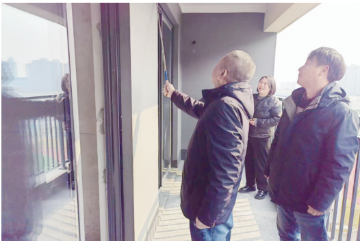
工程竣工验收监督“政府开放日”活动现场,大家在查验房屋墙壁是否有空鼓问题。
