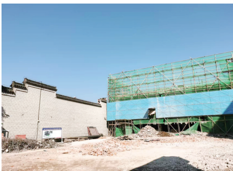
赵朴初故居东侧的一栋建筑正在封闭施工。
