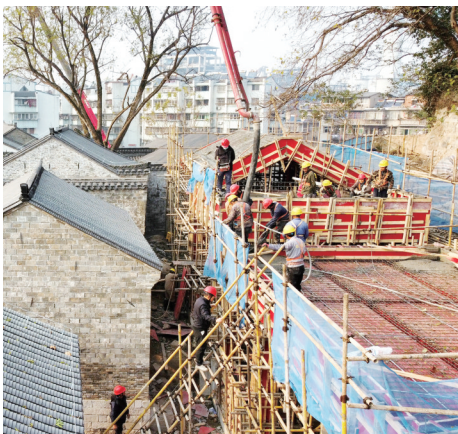
建设中的大观亭历史文化街区保护利用项目。
