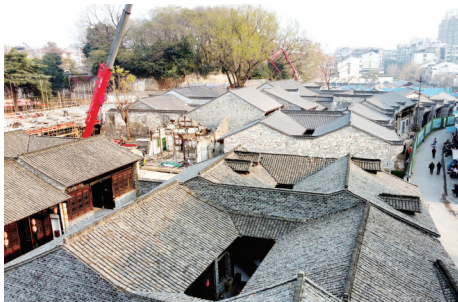
建设中的大观亭历史文化街区保护利用项目。
