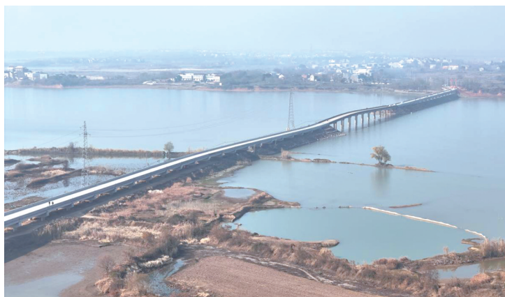
建成的长河大桥。通讯员 张勇 摄
