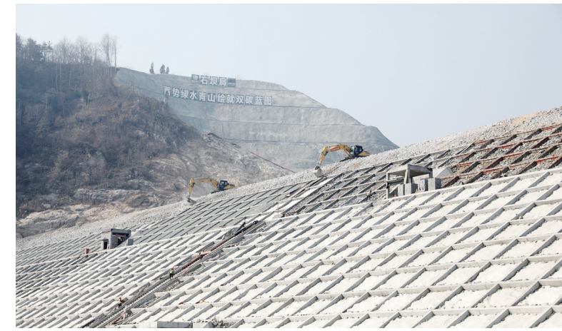
1月3日,国网新源安徽桐城抽水蓄能电站工程现场。
