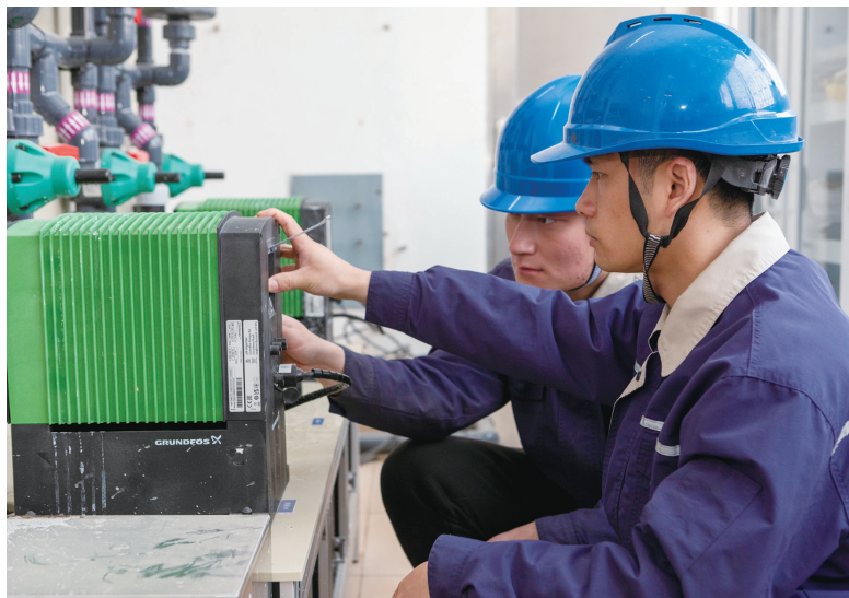
供水维修人员正在调试新加装次氯酸钠的药泵。
