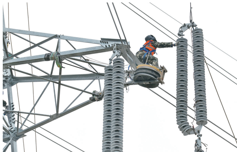
3月27日,国网沧州供电公司的工人在大白冢220千伏输电变电工程建设工地施工。
