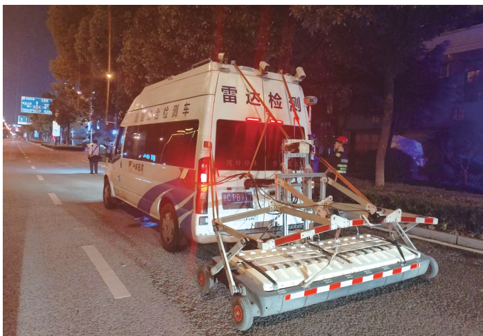
三维雷达车正在对道路进行地下病害检测。
