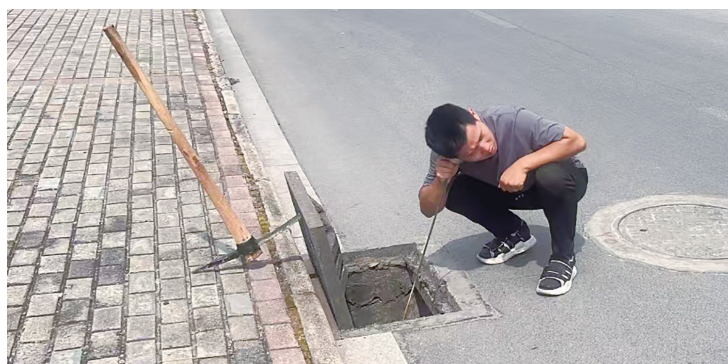
维修人员正在查找漏点。
