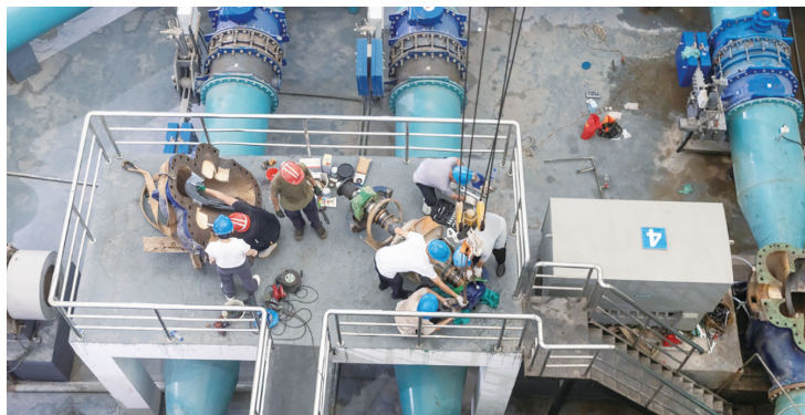
维修人员正在对4号泵进行维护保养。通讯员 顾春骏 摄
