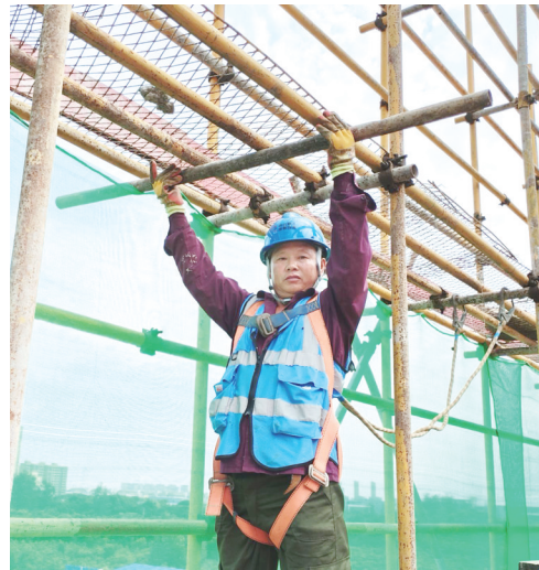
刘宽波正在搭建操作平台。
