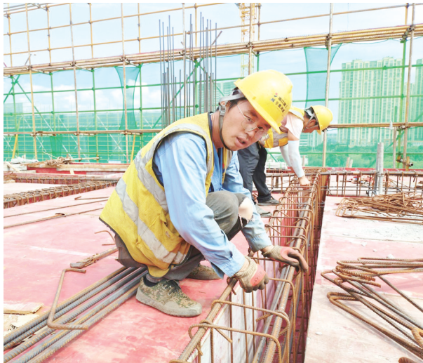
程刚正在绑扎钢筋。
