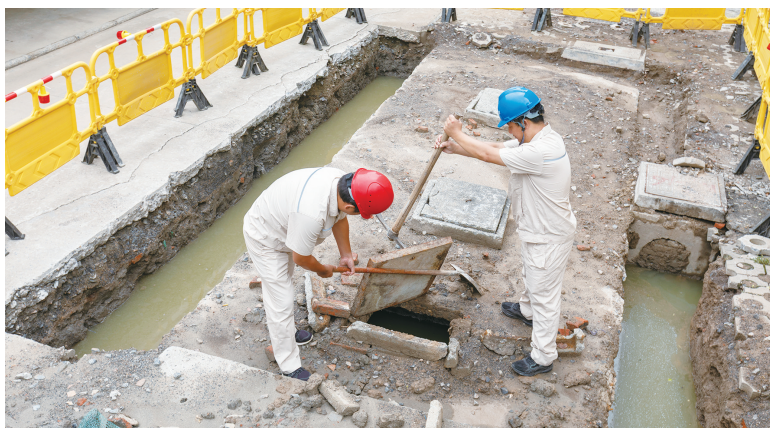
迎江区任店小区雨污改造工地,施工人员正在监护供水主管设施。
