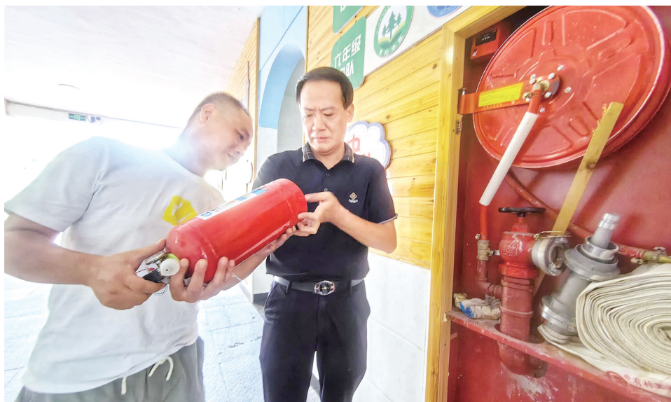
迎江区一小学老师和工作人员检查消防器材。全媒体记者 路欣 通讯员 王晶 摄
