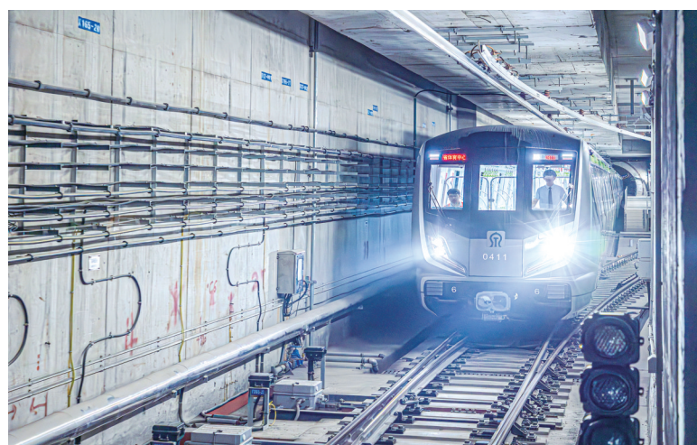
8月31日,济南地铁4号线列车开启试运行。8月31日,国内首条穿越泉域岩溶区地铁——济南地铁4号线开启试运行。济南地铁4号线沿济南东西向交通大动脉经十路敷设,全长约40公里。 新华社发
