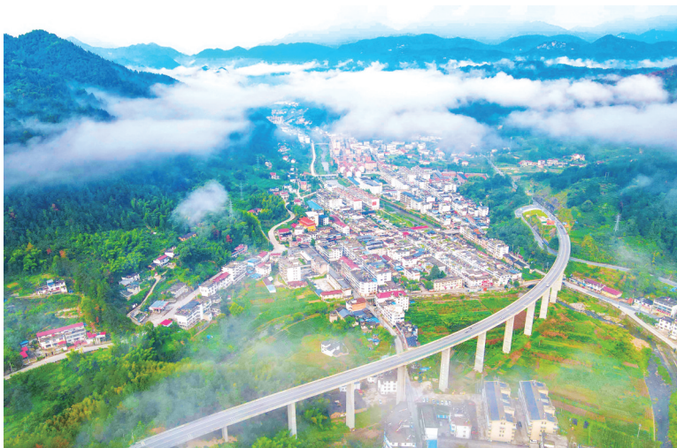
8月30日,在岳西县来榜镇来榜村一带,云雾缭绕,林木含秋,G318来榜大桥宛如巨龙横卧山间。近年来,岳西县持续加大交通基础设施建设力度,扎实推进道路提质改造和“瓶颈路段”改建工程,为乡村旅游和促进产业发展打下坚实的基础。 通讯员 吴均奇 摄
