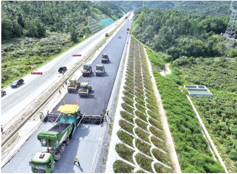
太蕲高速安徽段项目建设加速推进中。
