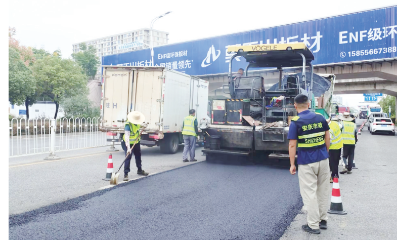
施工人员进行路面修复作业。
