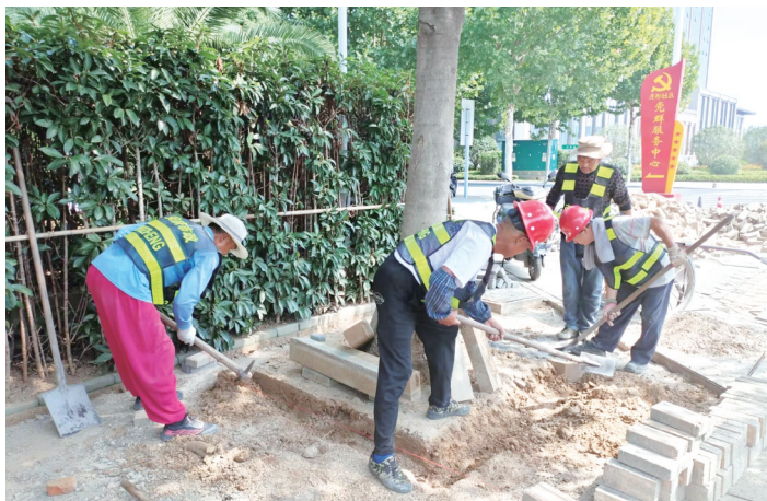
拱起的树围石。 市政人员正在天柱山东路人行道维修
