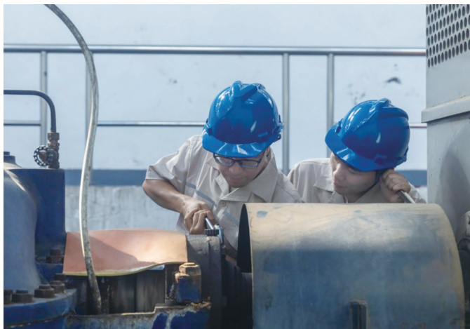
检修人员正在巡检供水设备。
