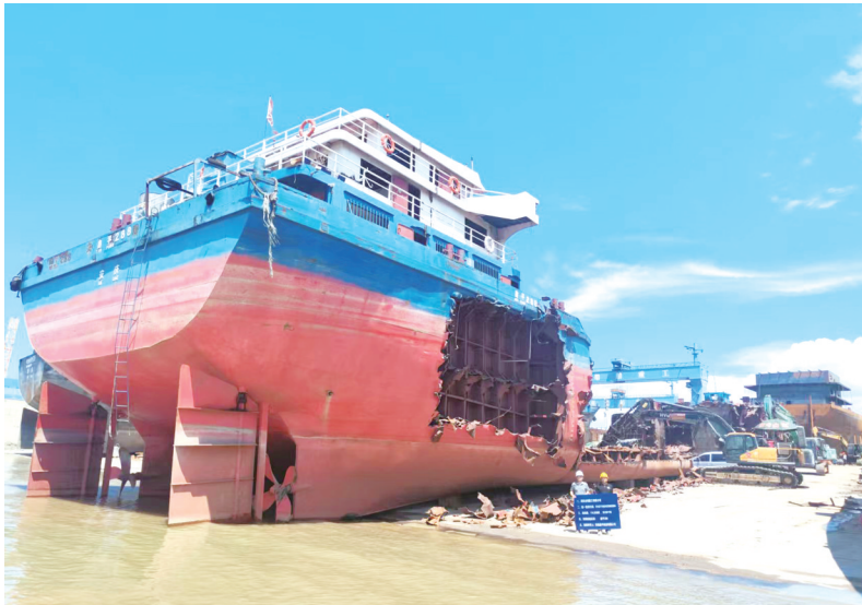
老旧营运船舶拆解工作现场。
