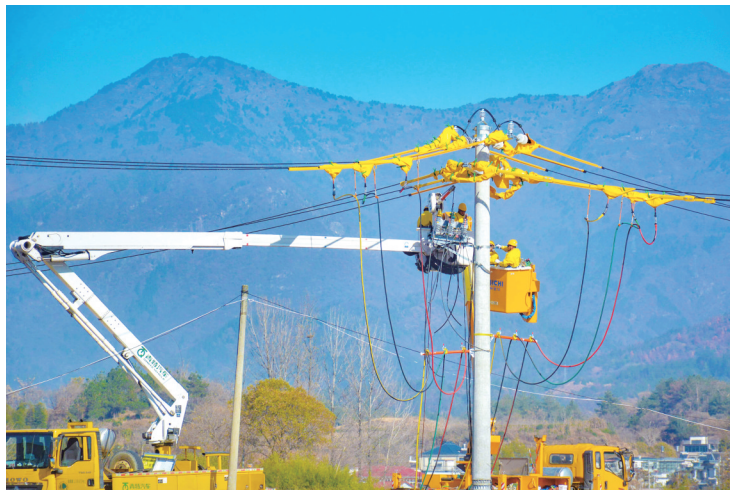
11月29日,在岳西县温泉镇资福村,电力工人在对线路进行升级改造。
