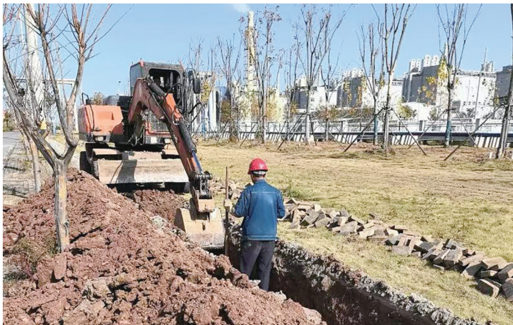
齐虹路施工沟槽开挖现场。
