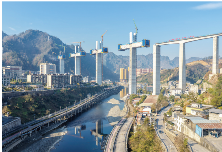
这是12月7日拍摄的西渝高铁任河特大桥建设现场（无人机照片）。12月7日，由中铁十二局承建的西渝高铁城口任河特大桥塔柱施工任务全部完成，全桥施工进度完成近七成，为西渝高铁全线按期贯通奠定了基础。
