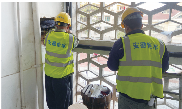
施工人员正在对菱湖新村小区户表进行改造。 通讯员 吴兆祥 摄
