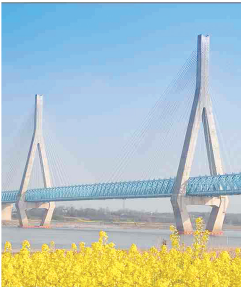
安庆长江铁路大桥。
