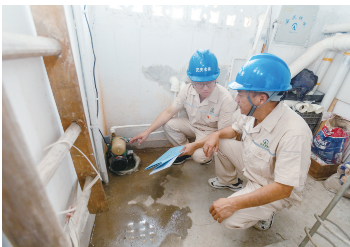
技术人员现场研定安装增压泵施工方案。
