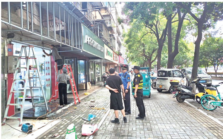
城管执法人员在排查户外广告招牌风险隐患。
