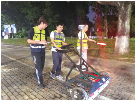
▶工作人员操作设备探测人行道路基情况。
