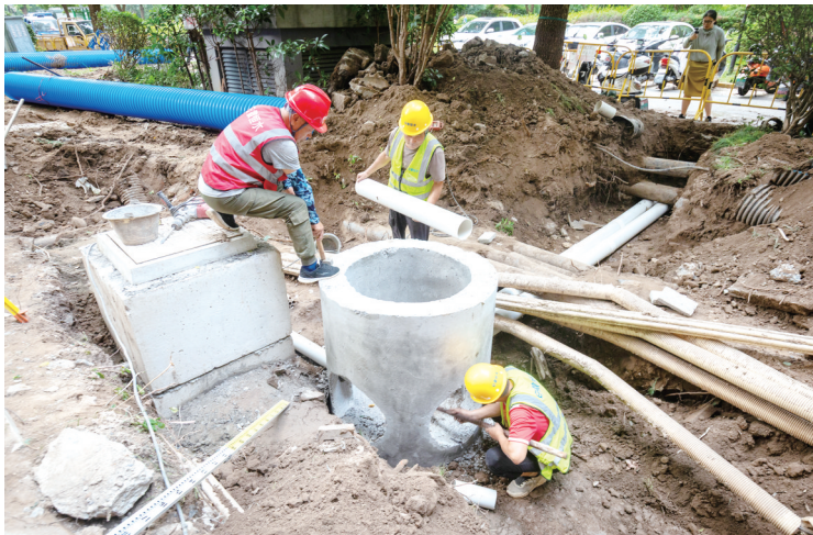
施工人员正在铺设污水井及管道。
