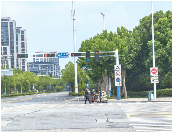
振风大道与顺安路交叉口的交通信号灯。
