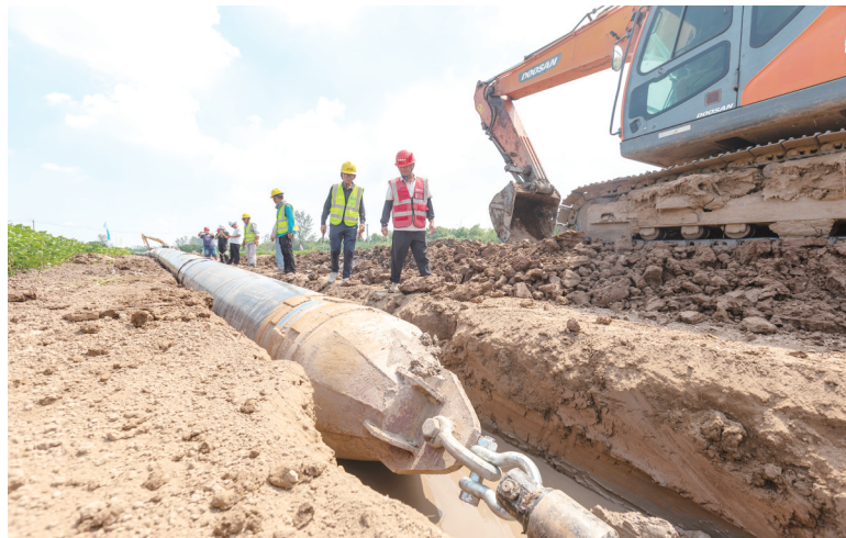
施工人员正在操作水平定向钻为DN800供水管道过河。 通讯员 颜春骏 文/图
