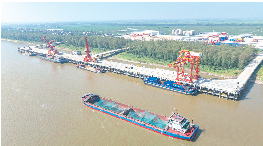
皖河新港一期工程。图片由通讯员提供
