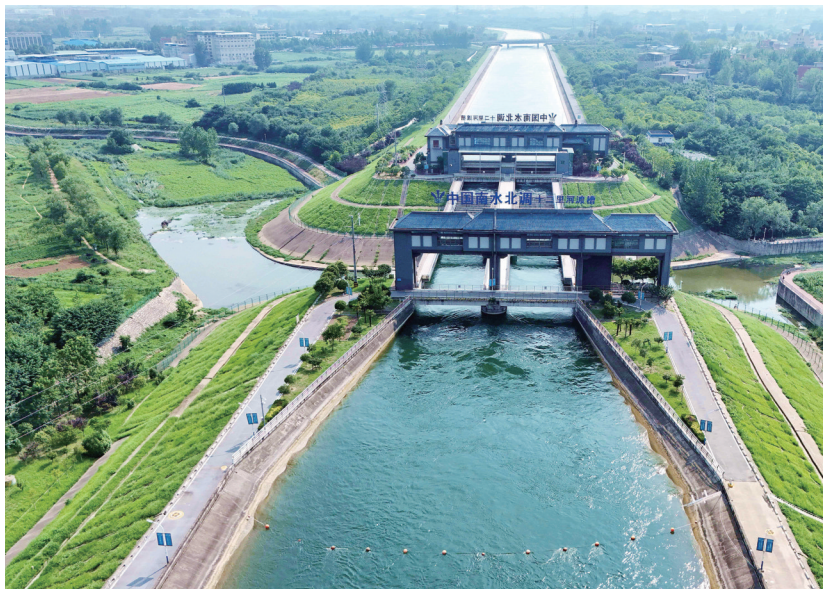
这是位于河南南阳的南水北调中线工程干渠十二里河渡槽(8月7日摄，无人机照片)。 新华社发(高嵩 摄)
