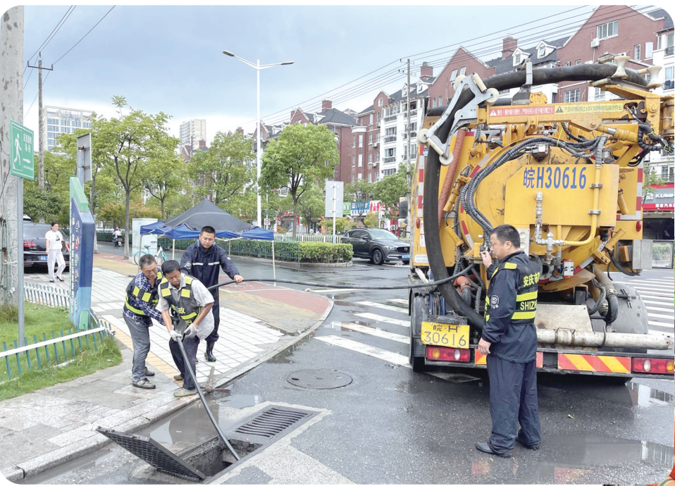
▲ 8月9日，市政部门正在城区主干道疏通排水管网。 全媒体记者 徐志远 摄
