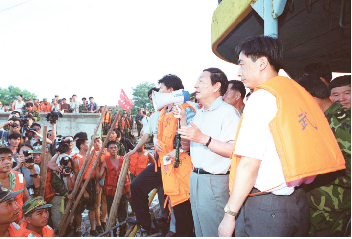
1998年8月9日，朱镕基同志在江西省九江市防洪墙堵口现场指挥抗洪抢险工作。 章武 摄
