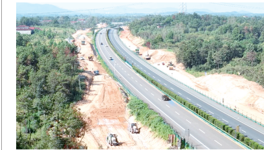
G50沪渝高速太宿段改扩建工程项目现场。 通讯员 张勇 摄
