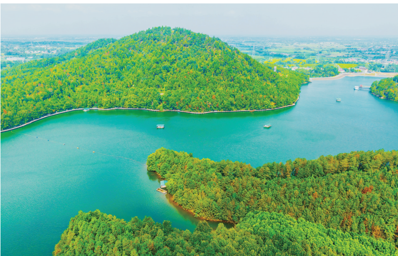
9月10日,怀宁县观音洞水库(航拍)。群山环抱之间,碧水澄澈如玉,茂密林木覆盖山丘,湖光山色相映如画。近年来,当地持续推进生态建设,扎实做好水源地保护工作,守护绿水青山。 通讯员 檀志扬 陈佳 摄
