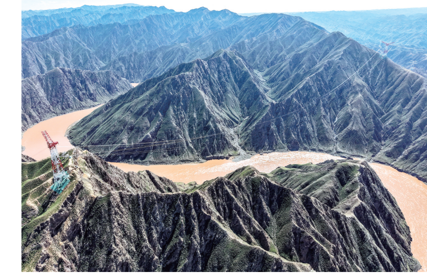
这是 9 月 14 日在甘肃省白银市景泰县和靖远县交界处拍摄的已经贯通的陇电入浙工程黄河大跨越段(无人机照片)。
