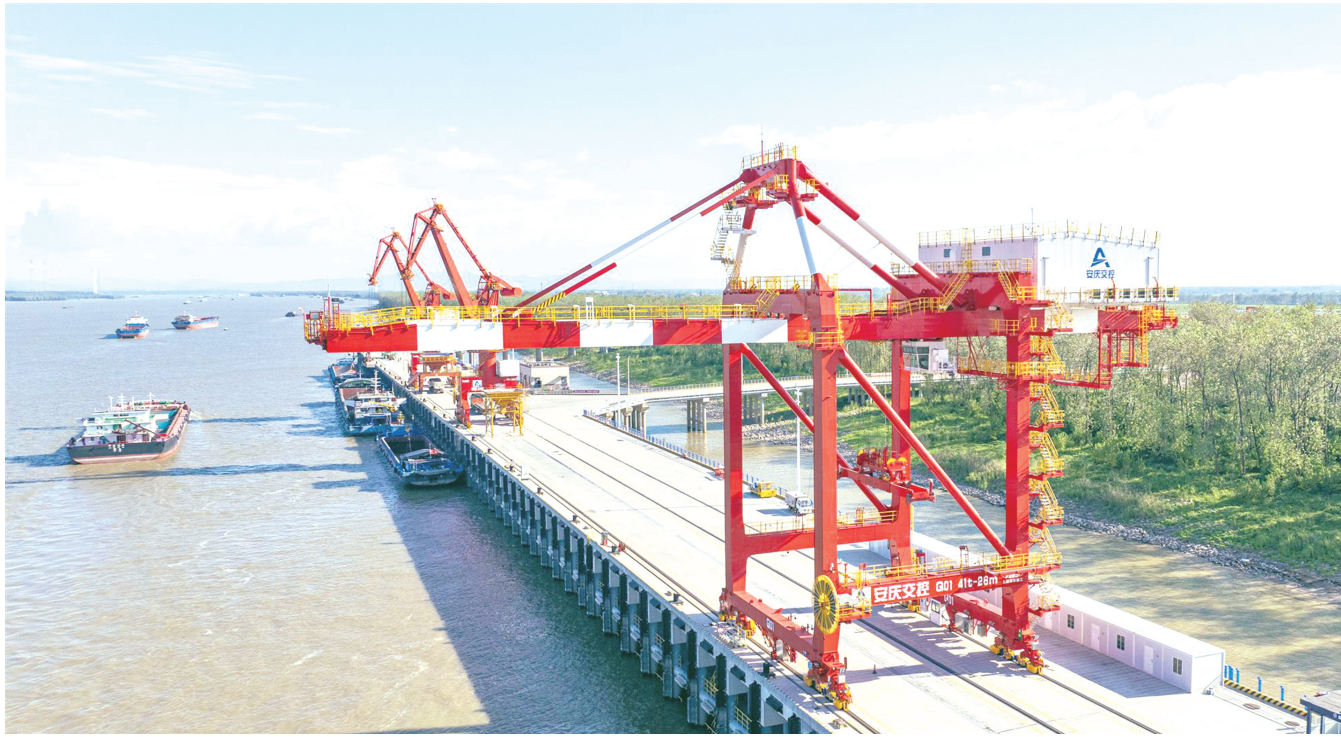
皖河新港一期工程。 通讯员 常家旗 摄
