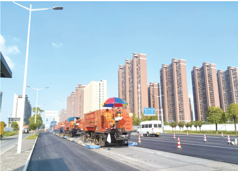
市政工程管理处利用就地热再生技术对迎宾东路进行升级养护。
