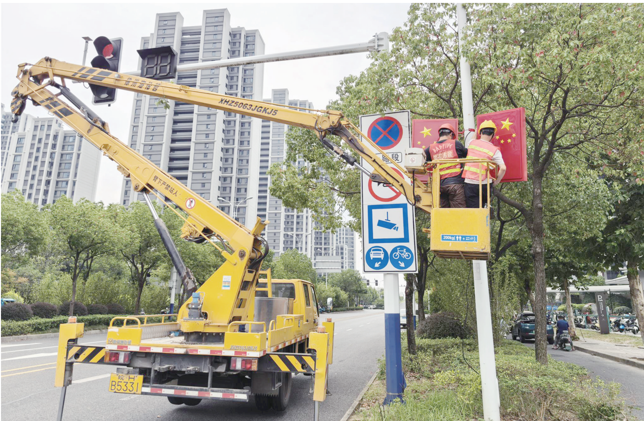
图为市政人员正在安装LED灯杆旗。 全媒体记者 徐志远 摄
